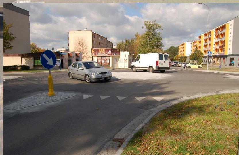
Remont ulicy Kościuszki
