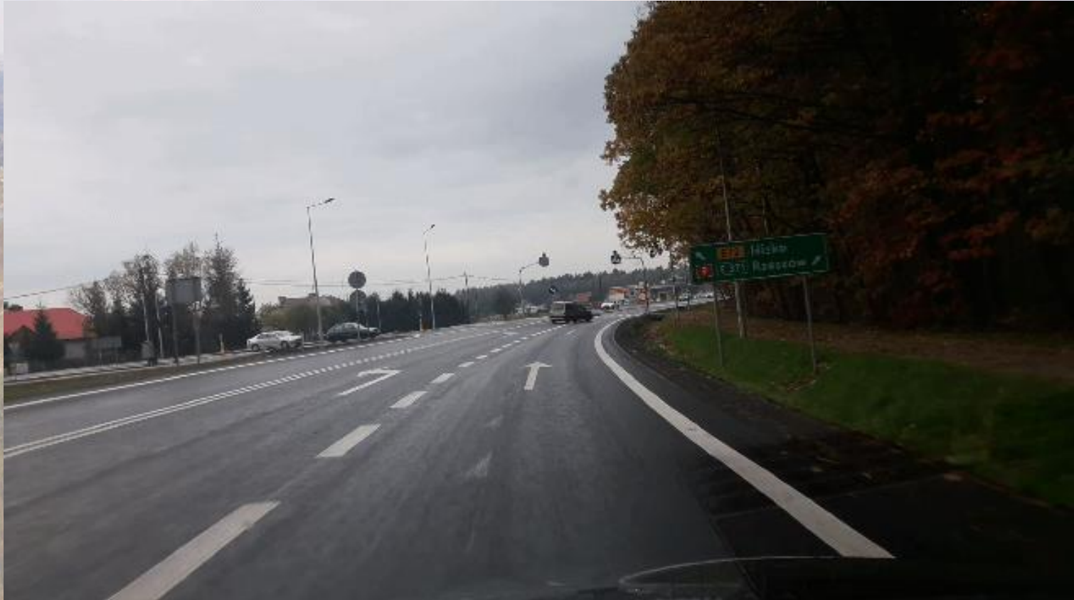
Przebudowany zjazd z DK9 na ulicę Niżańską
