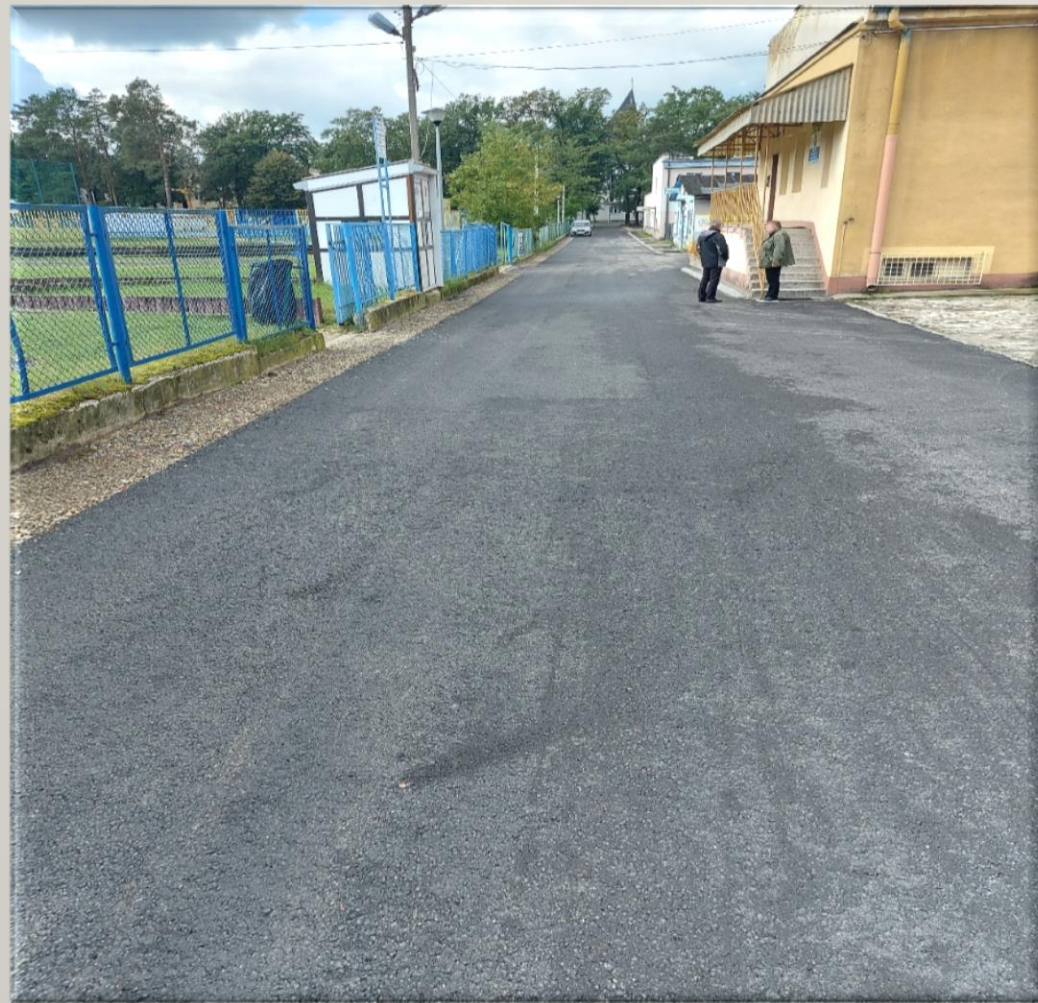
Remont ul. Sportowej w Nowej Dębie
