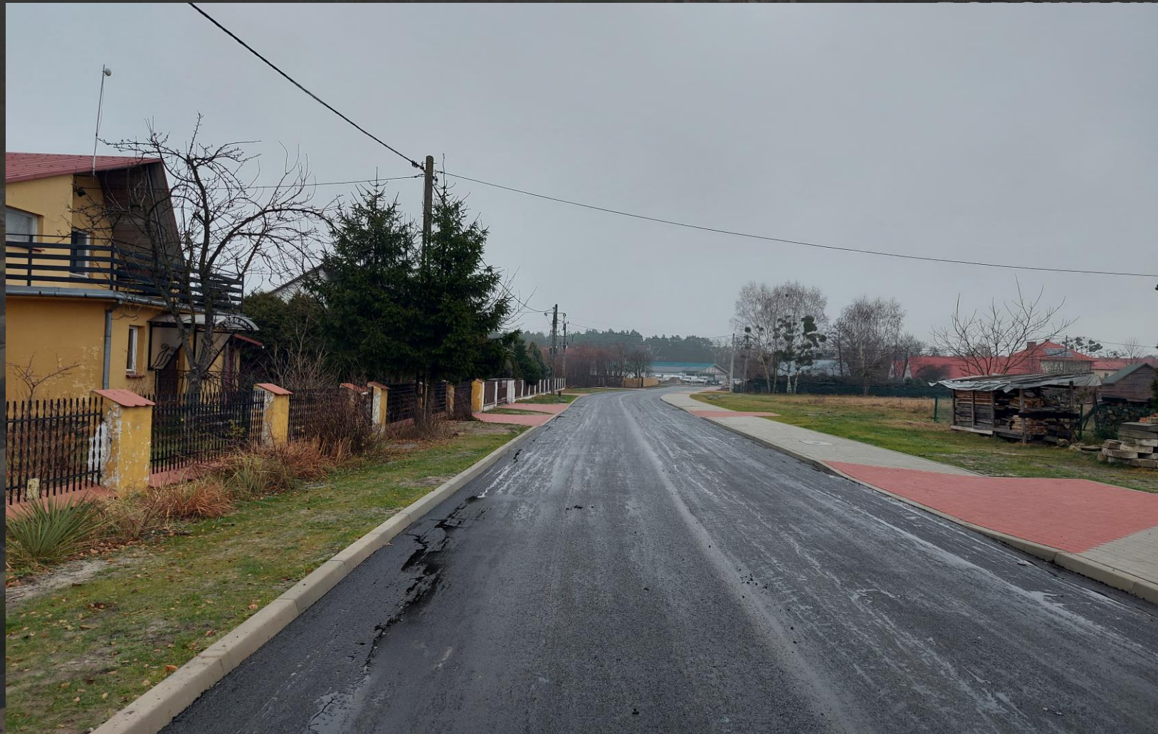
Budowa łącznika ul. Zarzecze – DK9 w Os. Dęba
