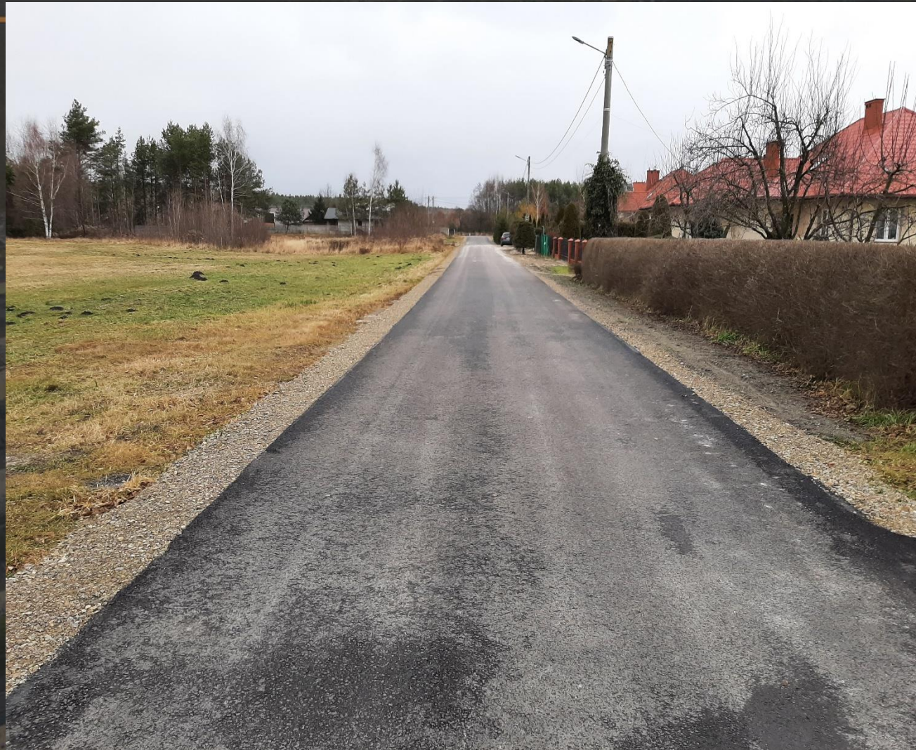
Budowa drogi na ODJ w Alfredówce
