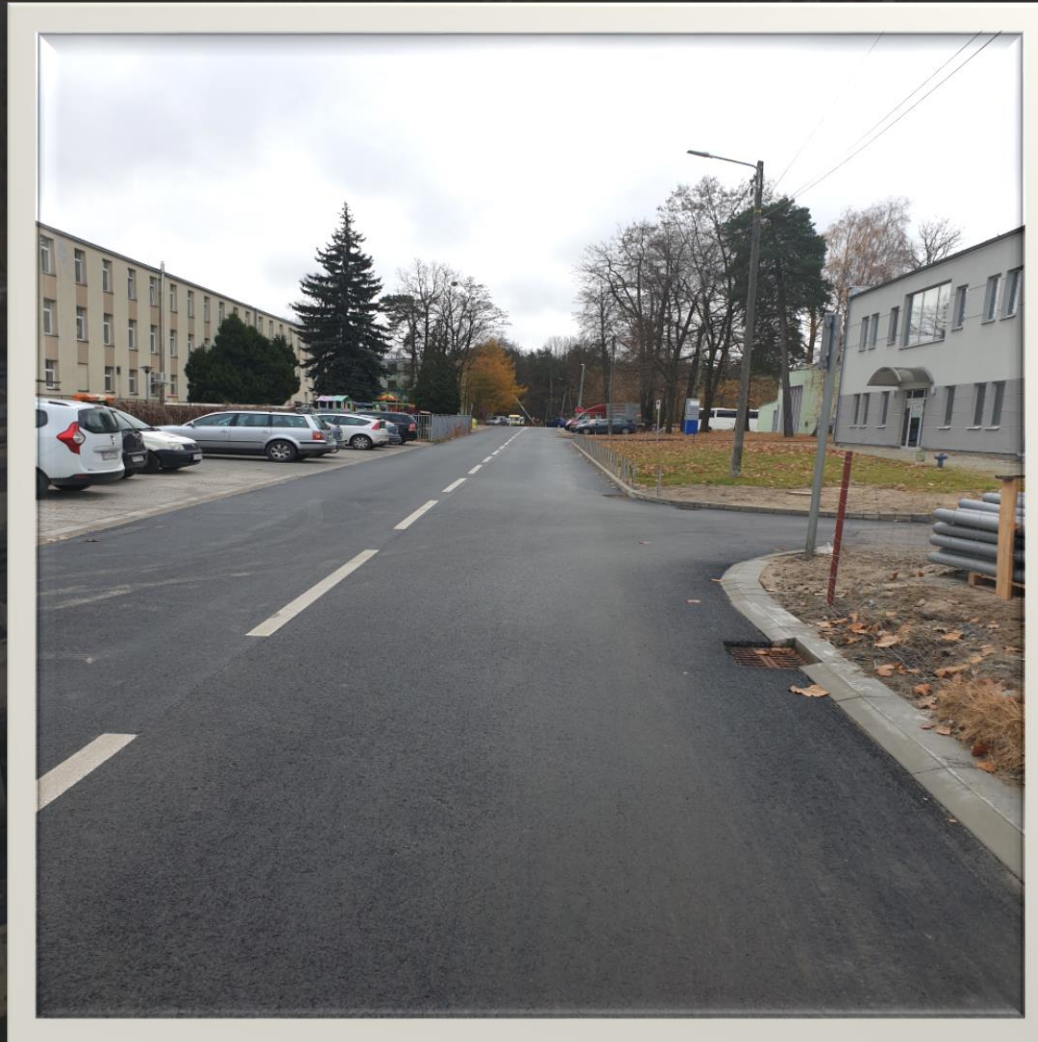
Przebudowa drogi na strefie w Nowej Dębie
