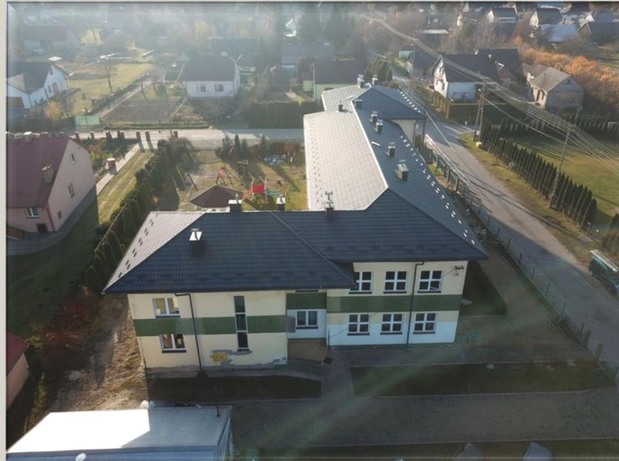
Szkoła w Tarnowskiej Woli z nowym dachem
