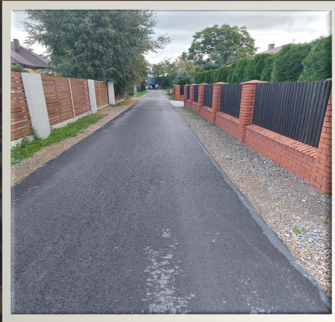
Remont ul. Kanałowej w Porębach Dębskich
