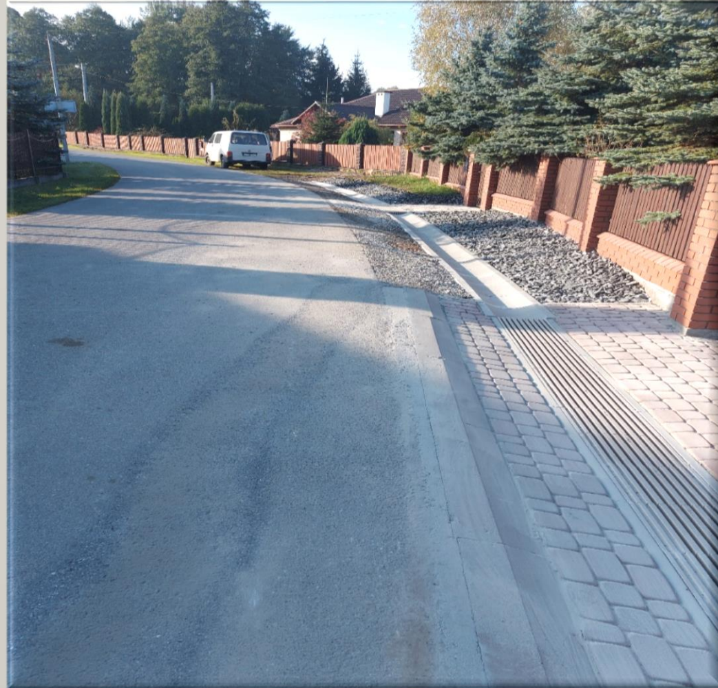
Odwodnienie ul. Hubala w Porębach Dębskich
