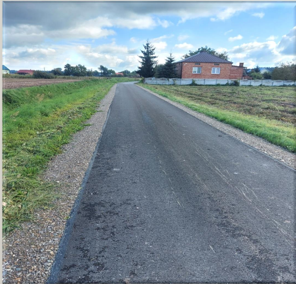
Budowa drogi Kamyczkowa-Boczna w Cyganach
