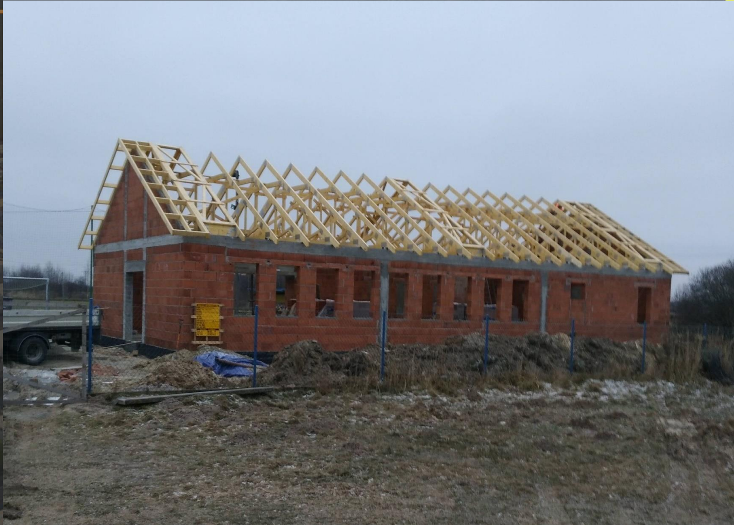
Rozpoczęły się prace przy budowie szatni sportowej w Jadachach
