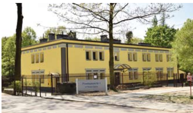
Przedszkole nr 1 po termomodernizacji
