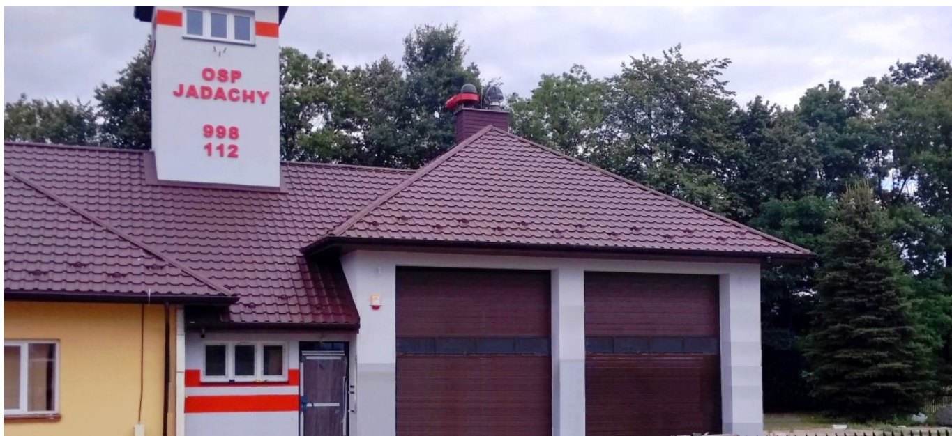
JADACHY — rozbudowa remizy OSP
