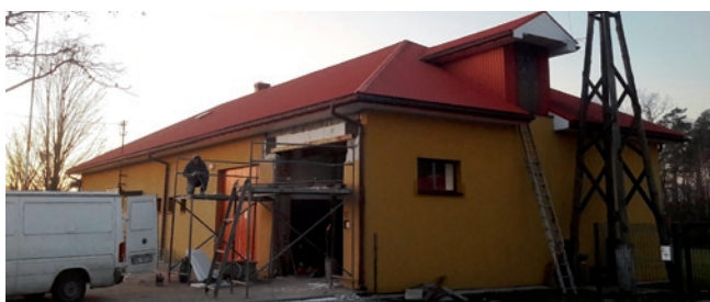
Przebudowa garażu w OSP Poręby Dębskie
