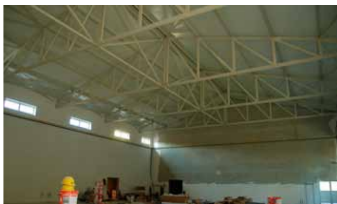
Wnętrze nowej hali sportowej przy SP 2 - październik 2015
